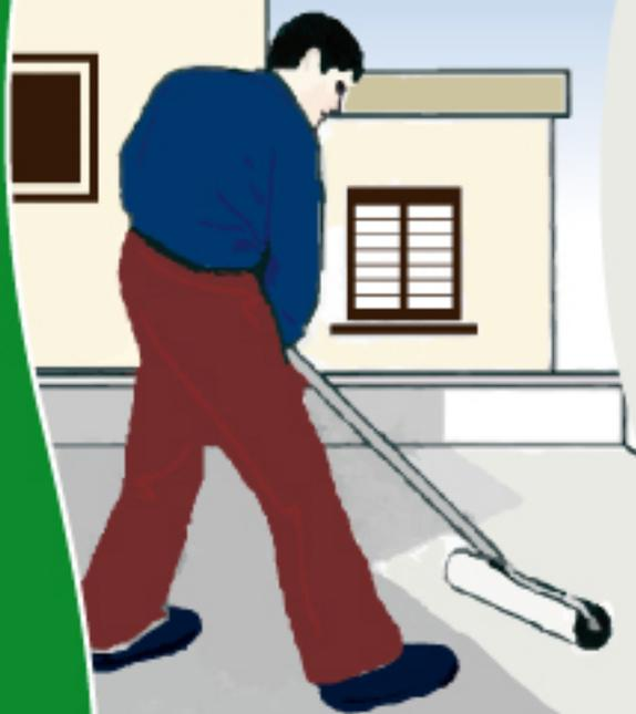
L'étanchéité liquide est un mode d'exécution utilisant l'application du produit «**SUPRAETANCHE**» formant, après séchage, un revêtement adhérent au support et résistant à la fissuration. L'étanchéité liquide offre les avantages suivants :
